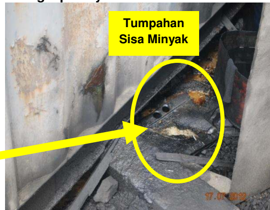
Gambar 3.9 Kemudahan Penyimpanan Bahan Minyak Tidak Mempunyai Sistem Saliran Dan Perangkap Minyak
