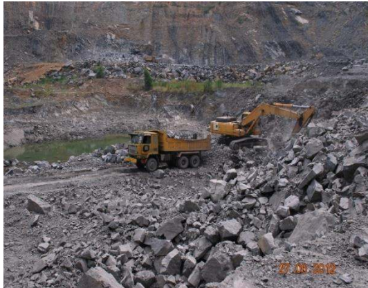
Gambar 3.17 Excavator Mengambil Batu Untuk Dimasukkan Ke Dalam Lori
