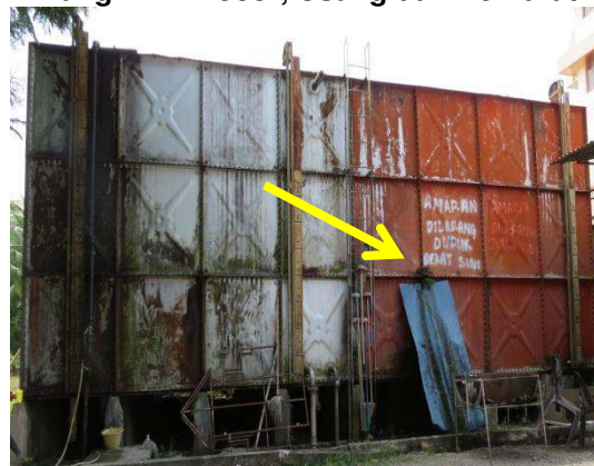
Gambar 6.13 Tangki Air Bocor, Usang dan Berkarat
