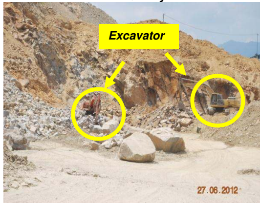
Gambar 3.19 Excavator Sedang Mengalih Batu Dari Kawasan Quarry Face
