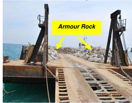
Gambar 3.14 Armour Rock Yang Dipindahkan Ke Dalam Barge
