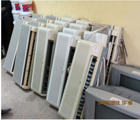
Gambar 6.20 Penyaman Udara Rosak Tidak Di Lupus
