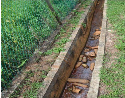
Gambar 4.5 Longkang Dipenuhi Tin Aluminium Dan Botol Plastik Kerana Tidak Dibersihkan
