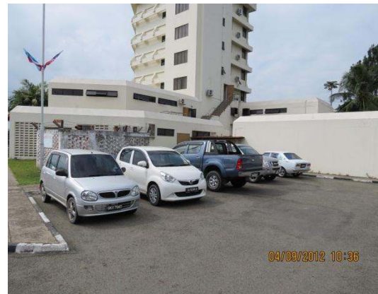
Gambar 6.15 Garisan Petak Letak Kereta Tidak Dibuat
