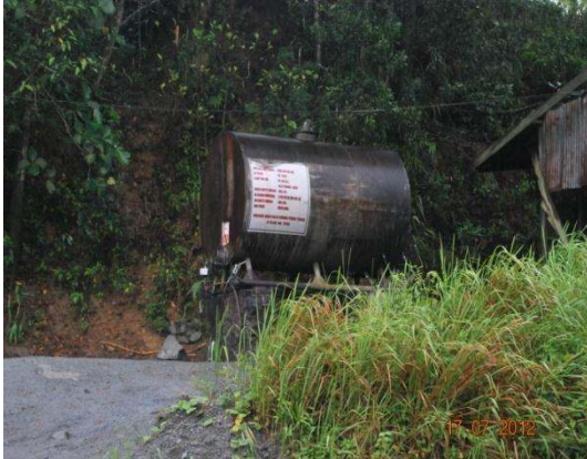
Gambar 3.7 Kawasan Penyimpanan Minyak Tidak Berbumbung
