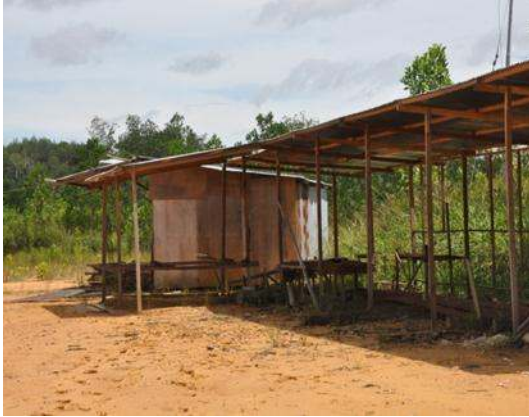
Gambar 7.13 Tempat Penyimpanan Bahan Binaan Tidak Berpagar/Berkunci
