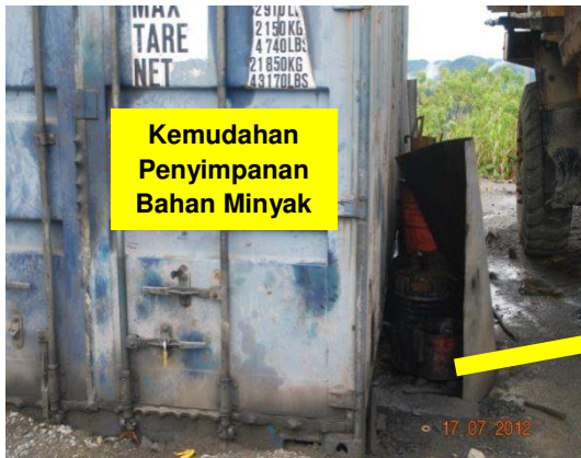
Gambar 3.9 Kemudahan Penyimpanan Bahan Minyak Tidak Mempunyai Sistem Saliran Dan Perangkap Minyak
